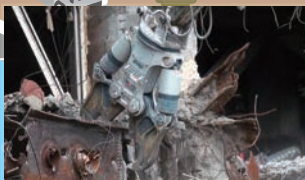
■圧碎機 ビル解体現場などでコンクリートの破碎や鉄骨・鉄筋の切断に使用されています。
