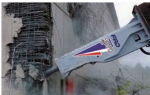
■油圧ブレイカ 岩石の小割りやコンクリートの破碎に使用されています。
