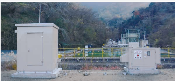
新設の非常用発電機
