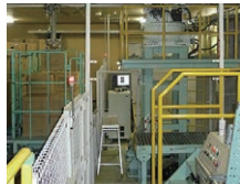
自動搬送設備
