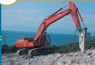
宅地造成工事
