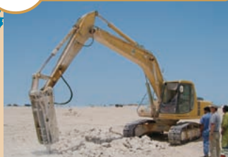
天然ガスパイプライン敷設工事
