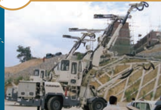
水力発電所ダム建設工事
