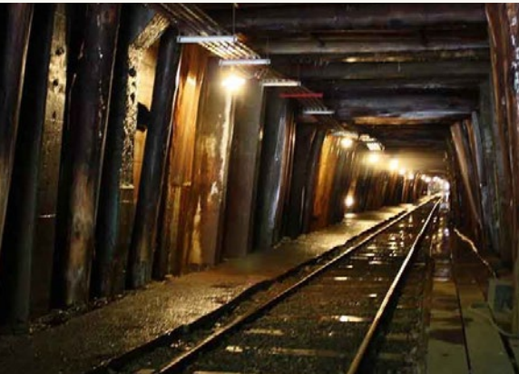
国指定史跡 通洞坑
