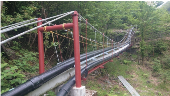
吊り橋補強工事
