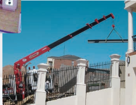
オーストラリア・アデレード (住宅建築現場)
