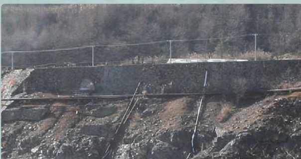
足尾製錬所法面(2009年)
