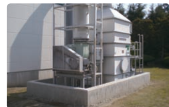
スクラパー防液堤改修 いわき工場
