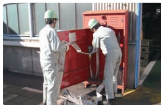
栃木工場 消火栓点検
