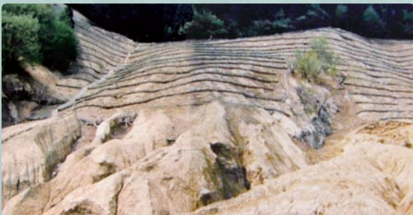
原堆積場傾斜部(1977年)
