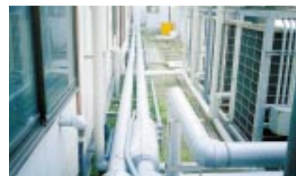
配管の地上配管への切り替え
