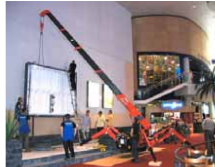
< 屋内でガラス据付中のミニクローラクレーン >
