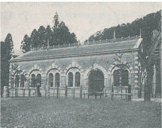
細尾第1発電所
