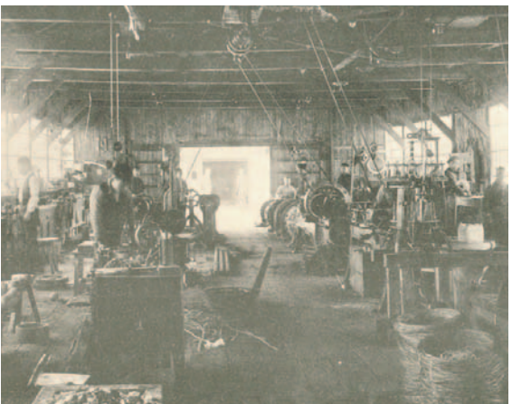
足尾電気機械修繕工場
