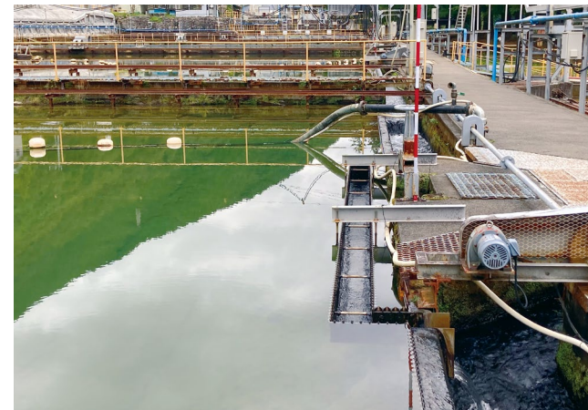
沈殿池越流堰延長工事(中才浄水場)
