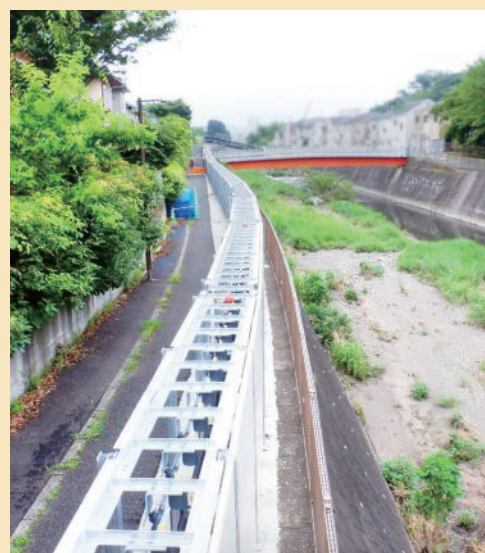
ベルトコンベヤ設置工事の様子
