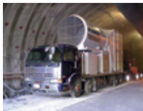
トンネル工事用電気集じん器
