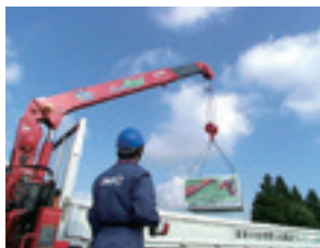
ユニッククレーン
