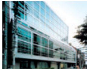
古河大阪ビル
