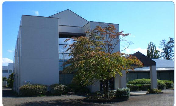
先端技術部・新材料開発部（茨城県つくば市）
