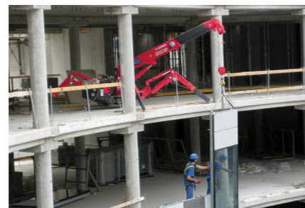
ミニ・クローラークレーン
