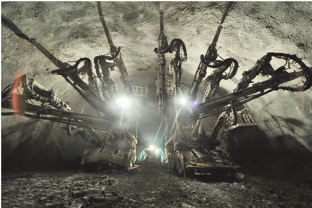
山岳トンネル工事の切羽（掘削現場）で使用され、岩盤に火薬装填用の孔をあける機械。当社は国内唯一のメーカーで、青函トンネルや関越トンネル、黒部第4発電所導水路など多くの現場で活躍。最近ではリニア中央新幹線の工事にも使用されています。
