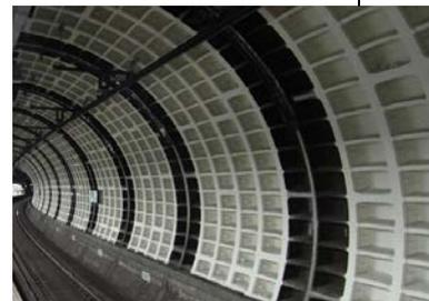
トンネル内鋼製セグメントの使用イメージ
