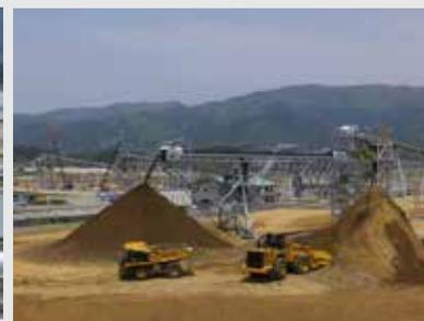
高台移転の造成工事において採用された**総延長約3km**の長距離ベルトコンベア。時速15km、搬送能力は6,000t/hを有し、10tダンプによる搬送と比べ**工期を1/3**に短縮可能。土砂の運搬は9月頃完了する予定となっている。
