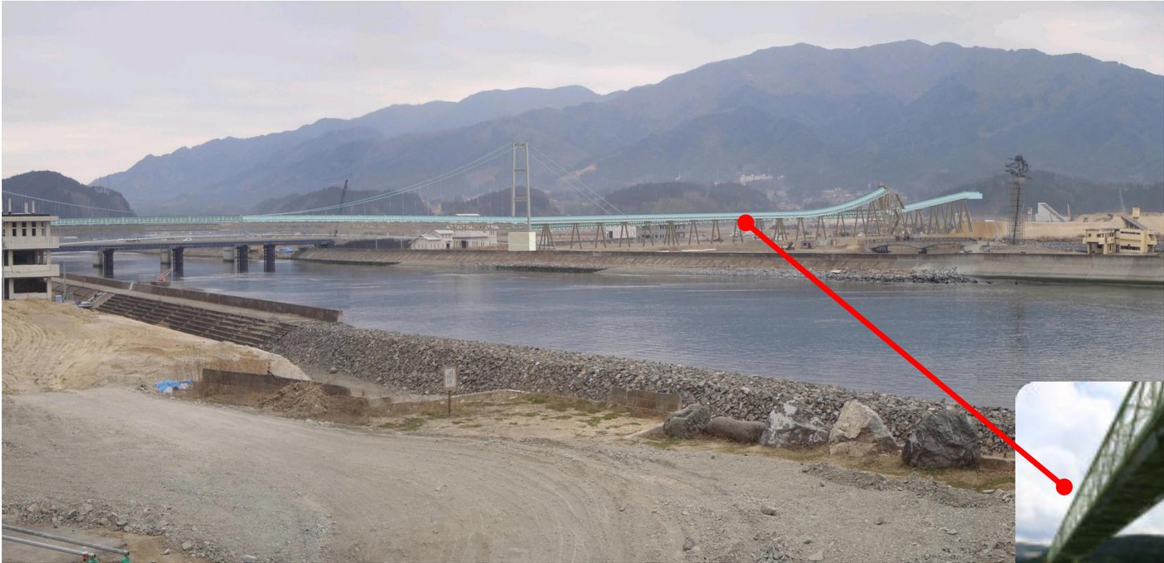
幅1-2m、距離1km級の長距離ベルトコンベアで嵩上げ地へ
