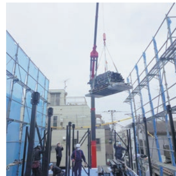
住宅密集地でのクレーン作業
