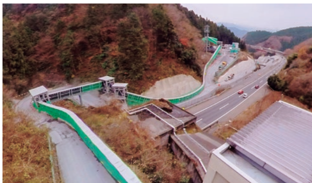
山間部トンネル工事に採用された密閉式吊下げ型コンベヤ (SICON®)
