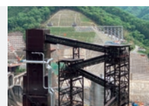
ダム関連工事
