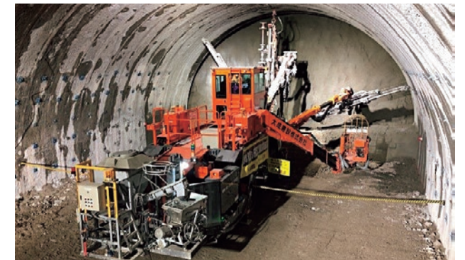
ロックボルト施工機「BOLTINGER(ボルティンガー)」
