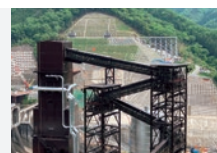
ダム関連工事
