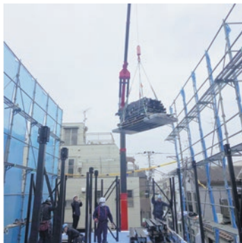
住宅密集地でのクレーン作業
