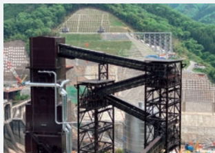
ダム関連工事
