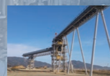
2011(平成23)年 岩手県陸前高田市の高台移転工事 (東日本大震災の復興に貢献)
