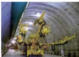
道路や鉄道の山岳トンネル工事で使用され、国内では圧倒的な実績があるトンネルドリルジャンボ
