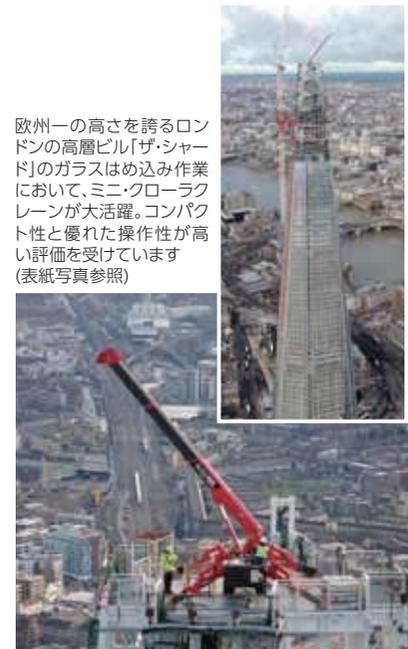
欧州一の高さを誇るロンドンの高層ビル「ザ・シャード」のガラスはめ込み作業において、ミニ・クローラクレーンが大活躍。コンパクト性と優れた操作性が高い評価を受けています(表紙写真参照)
