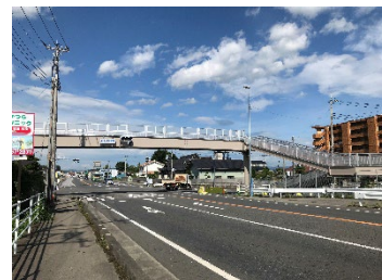
国道4号大原間南横断歩道橋
