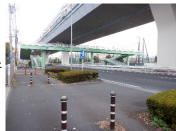
国道17号新大宮バイパス横断歩道橋
