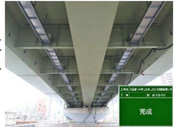
国道 16 号町田立体上部工検査路
