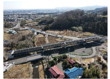
国道 246 号厚木秦野道路鈴川橋
