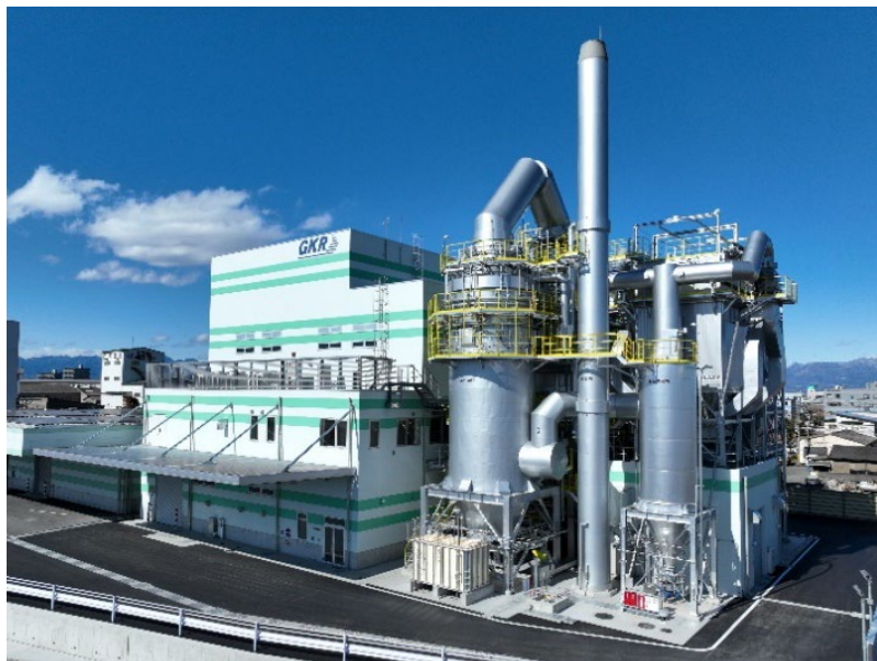
2号焼却炉全景
