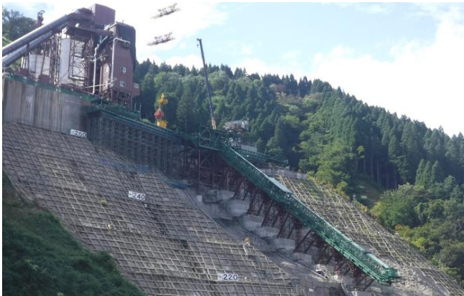
足羽川ダム本体建設工事に設置された SC プレミアムベルコン ®
