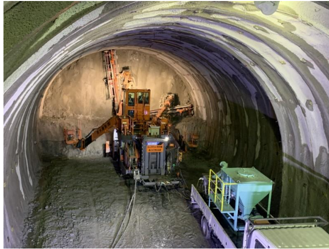
コンピュータ制御により施工の一連の工程を機械化したロックボルト打設専用機
