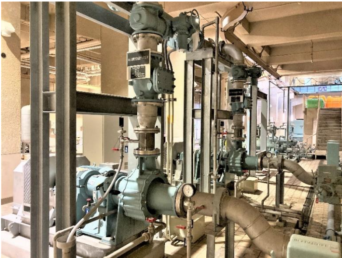
千島下水処理場ポンプ設備イメージ
