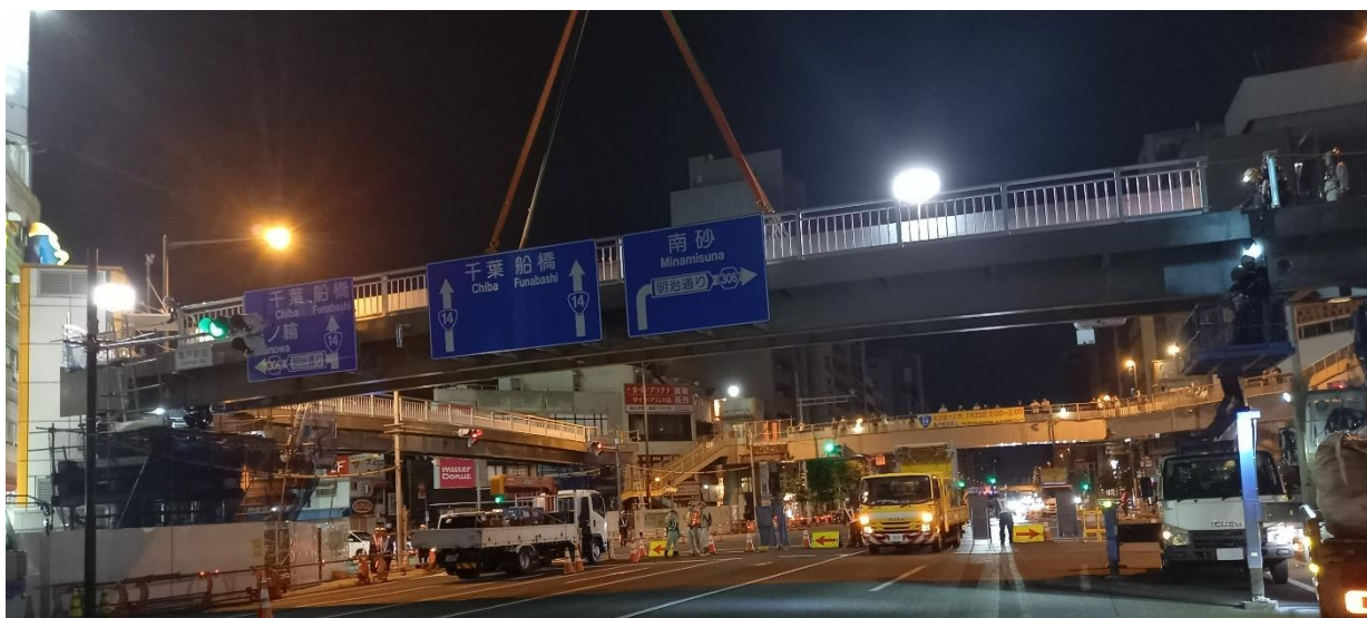
施工中の様子
