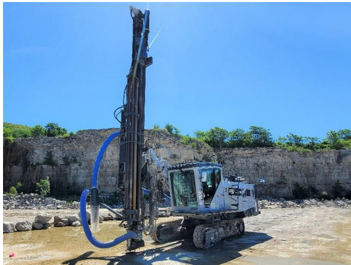
油圧クローラドリル（砕石場）
