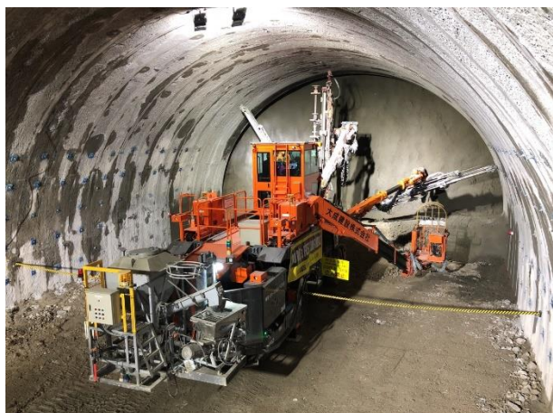
6m 継ぎボルト打設装置を搭載した ロックボルト専用ロボット「BOLTINGER」
