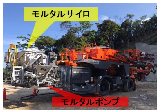
モルタル供給一体化
