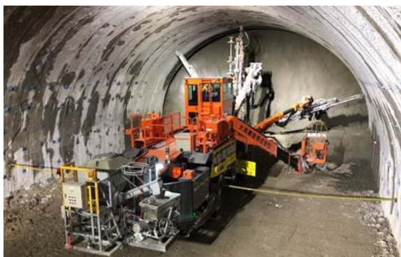
6m 継ぎボルト打設装置を搭載した ロックボルト専用機「BOLTINGER」
