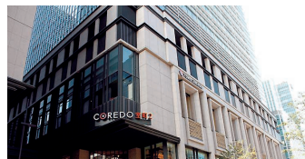
室町古河三井ビルディング
